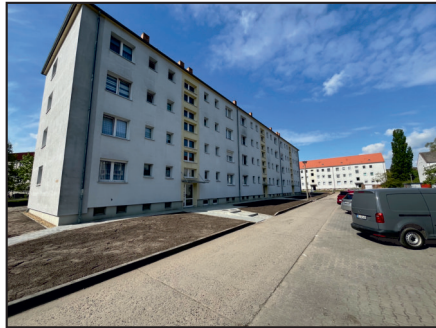
Tiefbauarbeiten Str. der AWG
