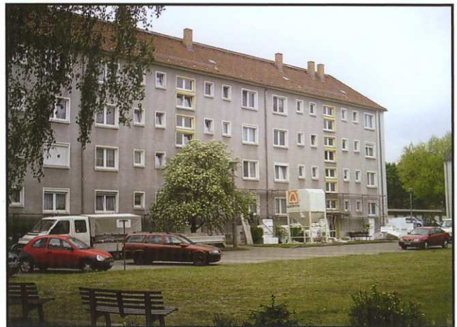
Fassadendämmarbeiten in der Str. der AWG 7-9
