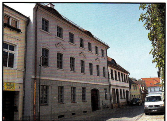
Nach der Fertigstellung
